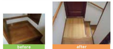
2Fのトイレ前に階段の段差があるため、床をかさ上げし階段の形状を変更することにより安全に移動する。
